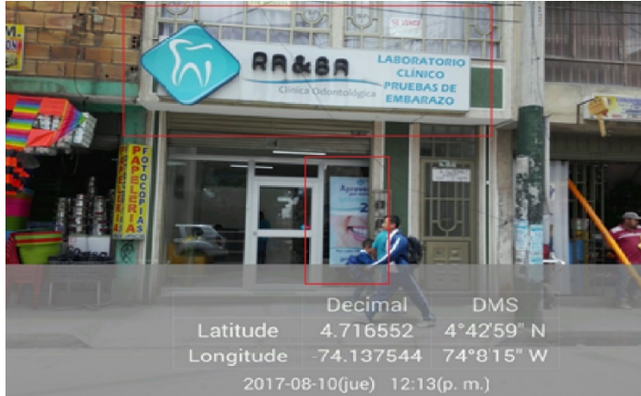
Fotografía No. 2: AVISO DE FACHADA EN EL QUE SE EVIDENCIA QUE SE ENCUENTRA UBICADO EN FACHADA NO PROPIA PUESTO QUE SOLO FUNCIONAN EN EL PRIMER PISO. ADEMÁS, ESTÁ VOLADO Y CUBRE LA VENTANA DEL SEGUNDO PISO Y PUBLICIDAD ADHERIDA EN EL VIDRIO
